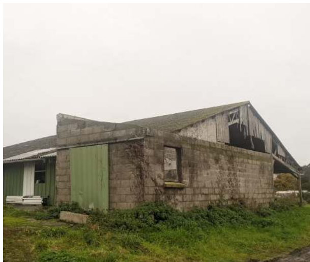
Figure 4: Après dépose de la charpente
