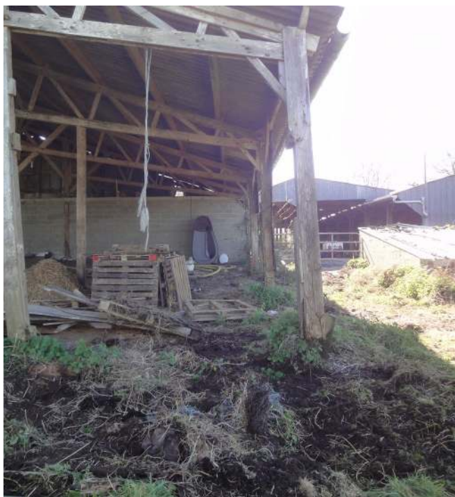
Figure 1: Exemple de reprise de charpente sur un poteau désolidarisé de son embase et dégradé
