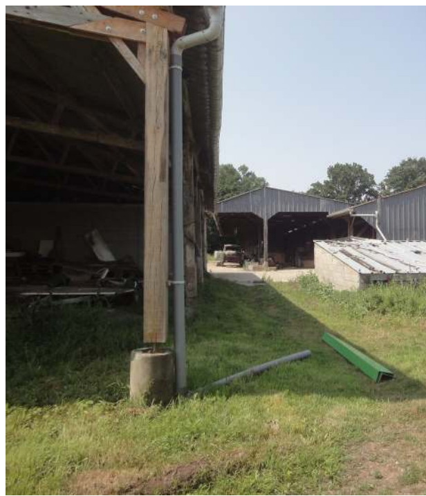
Figure 2: Le même poteau après remplacement
